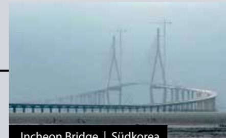
Incheon Bridge | Südkorea
