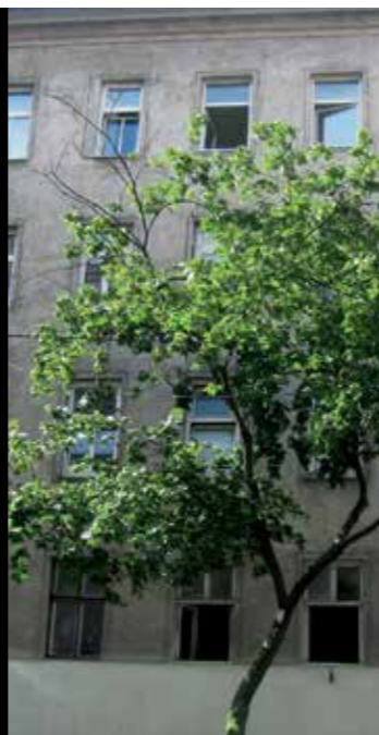
Das Gebäude in der Fendgasse (5. Bezirk, Wien) wurde mittels Unwuchterregers in Schwingungen versetzt. Die Gebäudeantwort wurde an der Fassade mittels eines Laser Doppler Vibrometers über vier Stockwerke erfasst. Die Abbildungen (links) zeigen verschiedene Schwingungsantworten bei unterschiedlichen Frequenzen.
