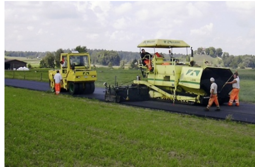
Abbildung 22: Einbau Deckschicht auf neuer Tragschicht [Foto: Hüppi-Bau]
