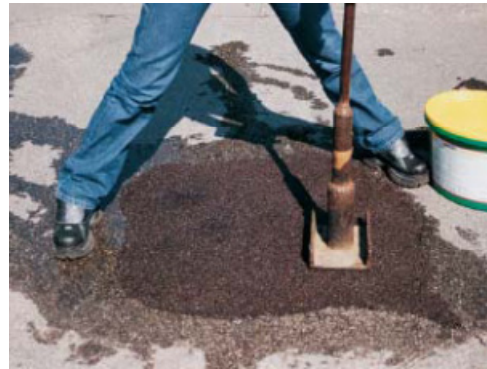
Abbildung 15: Verdichtung von Füllmaterial in einem Schlagloch [Foto: Vialit]
