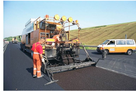
Abbildung 20: Einbau Dünnschichtdecke [Foto: ARGE Mikrobelaag]
