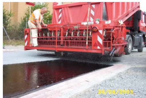
Abbildung 19: Oberflächenbehandlung, Absplittung
