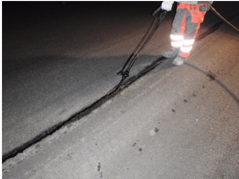
Abbildung 13: Vergießen von Rissen [Foto: Nievelt]
