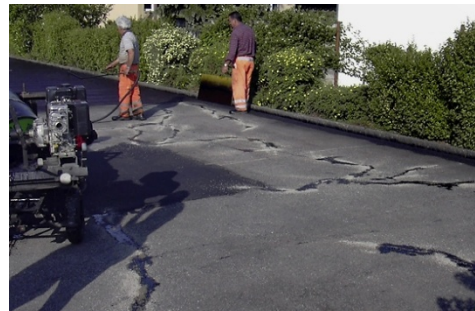
Abbildung 11: Instandhaltung (Rissverguß) [Foto: Hüppi-Bau]
