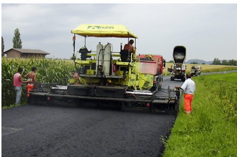
Abbildung 21: Deckeneinbau [Foto: Hüppi-Bau]
