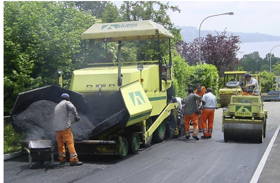
Abbildung 18: Instandsetzung Decke [Foto: Hüppi-Bau]
