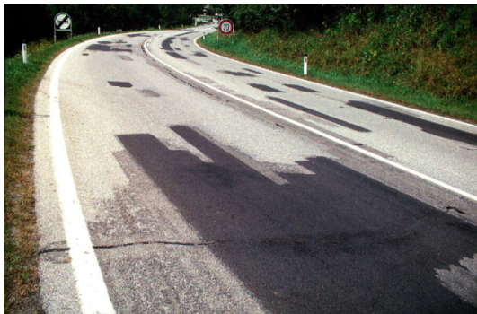
Abbildung 16: Oberflächliche Flickstelle [Foto: Streckel]
