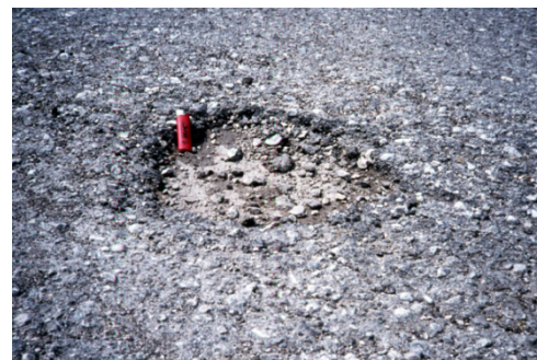
Abbildung 14: Schlagloch [Foto: Streckel]
