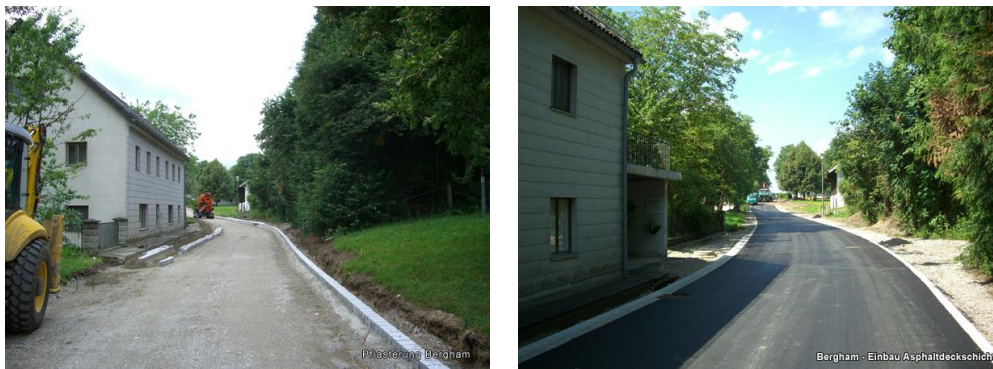
Abbildung 27: Erneuerung einer kommunalen Straße [Foto: Behringer]
