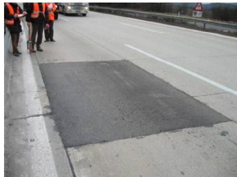
Abbildung 17: Reparaturstelle aus Asphalt auf Betonstraße [Foto: Sommer]
