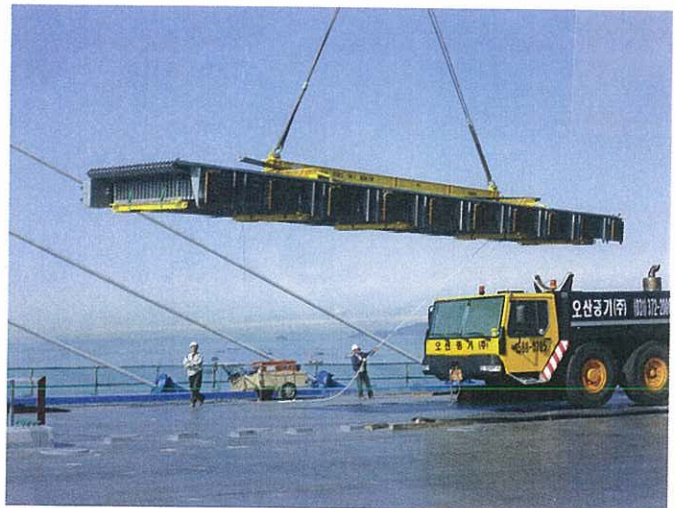
Bild 3. Montage der Lamellenfuge
