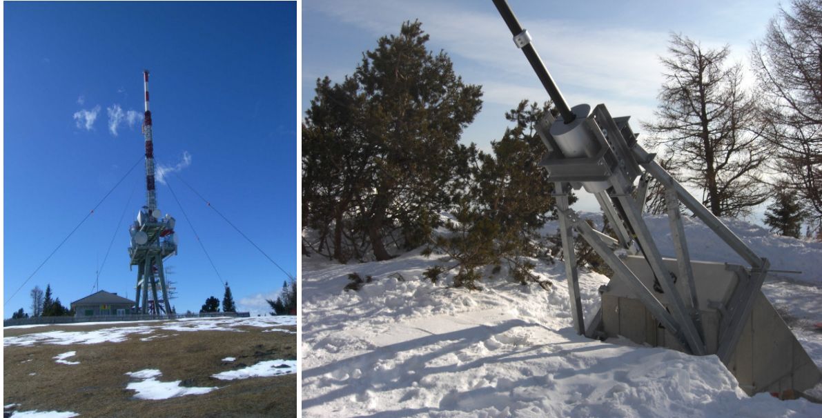
Bild 8: Sendemast am Schöckl und Seilabspannung mit montiertem Dämpfer
