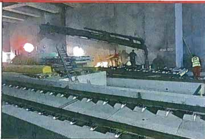
BILD 3.3: Einbau der „Festen Fahrbahn“ in den MFS-Trog
